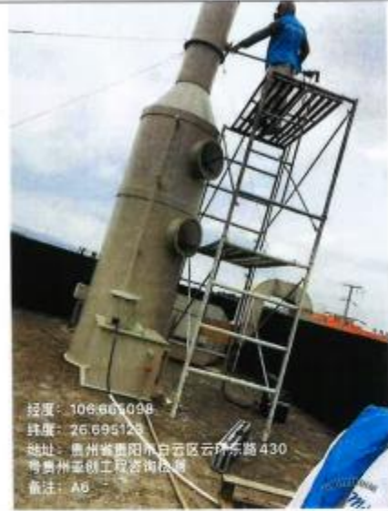
有组织废气采样照片
